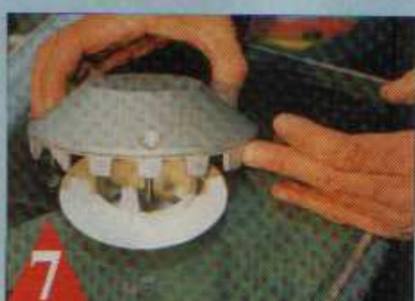
Le conduit en plastique, qui sert également de support au corps en aluminium, est alors mis en place avec un joint de silicone translucide Soromap (5 et 6), qui assurera l'étanchéité au ruissellement. Le corps en alu doté de trois vis coiffera l'ensemble (7).
