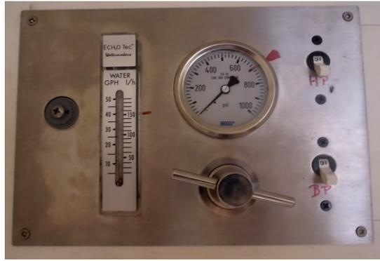
Sur le tableau de commande dans la douche, 2 disjoncteurs qui commandent la pompe hp et bp, un manomètre haute pression, un robinet de montée en pression, un débitmètre et une vanne trois voies de production dont la poignée a été retirée.
