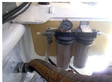
Dans le double porte-filtre, un filtre 20 microns en entrée et un filtre 5 microns, le manomètre indique le colmatage des filtres ; il n'y a pas beaucoup de pression bp car la hp aspire derrière mais remplacer les filtres lorsque l'on est proche du 0. Les filtres peuvent être rincés avec une douchette de pont, ne pas les frotter à la brosse car les pores vont se fermer ; être vigilant lors du remplacement des filtres, ne pas les inverser.
