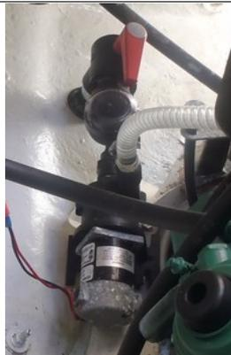
Ensuite le double porte-filtre avec la vanne trois voies permettant le stockage ou nettoyage du système.
